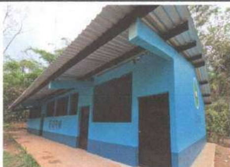
Foto 5: Se observa la sustitución de puertas y mantenimiento de balcones
