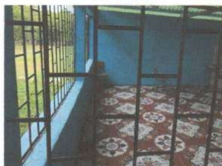
Foto 6: Se observa el piso colocado
