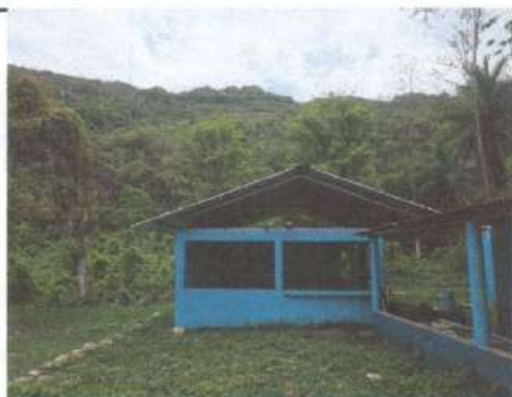
Foto 3: Se observa la sustitución de techo y estructura efectuada
