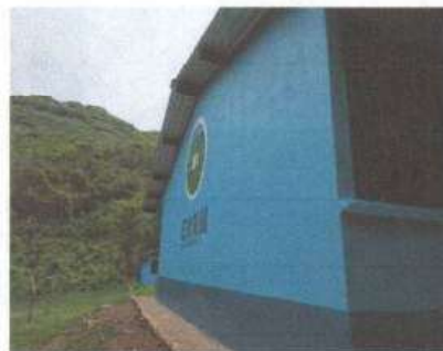
Foto 2: se observa el entechado nuevo
