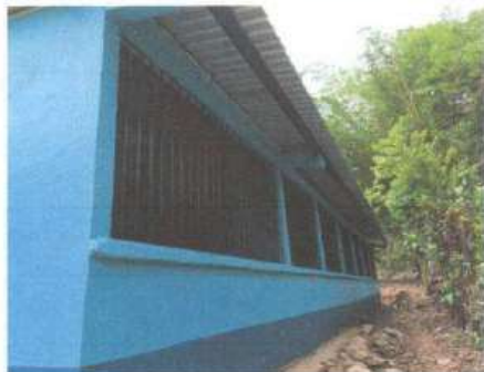
Foto 1: Se observa la estructura nueva
